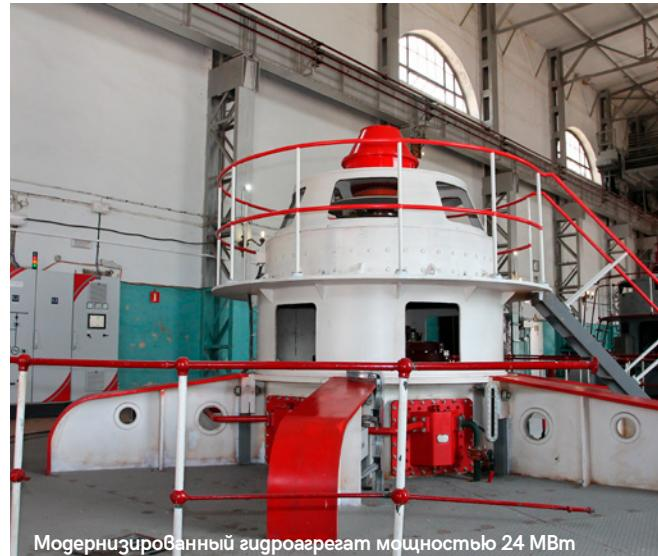
Модернизированный гидроагрегат мощностью 24 МВт
