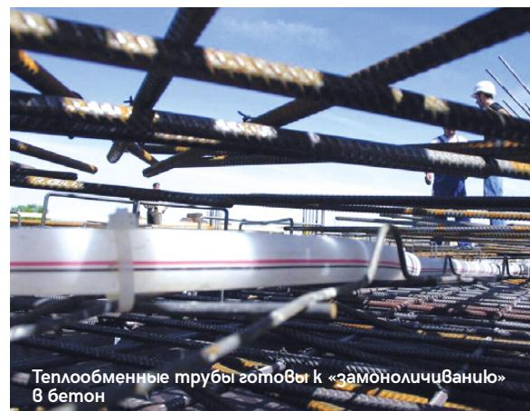
Теплообменные трубы готовы к «замоноличиванию» в бетон
