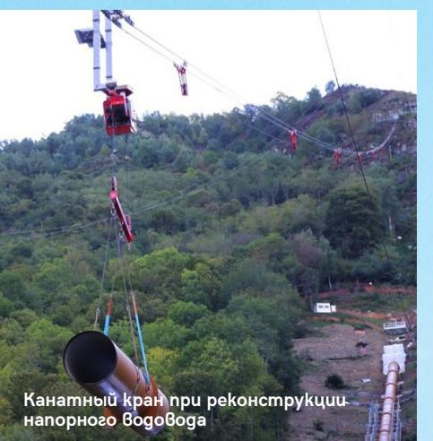
Канатный кран при реконструкции напорного водовода
