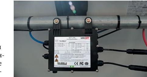
ные силовые блоки, которые подключаются к каждому солнечному модулю и регулируют параметры напряжения и тока на его выходе. Например, если модули включены последовательно и какой-то из них оказался не совсем исправен или временно затенён, имеет смысл уменьшить его напряжение, но сохранить прежний ток, чтобы остальные модули в цепочке продолжали работать в наиболее эффективном режиме.
